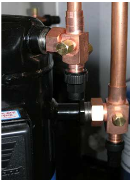
Chladicí kompresor je na chladicí potrubí připevněn uzavíratelnými trojcestnými armaturami
