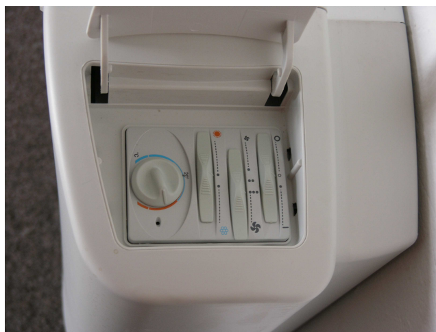
Regulátor vnitřní teploty fancoilu
